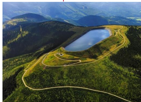
Obrázek 5: Přečerpávací elektrárna Dlouhé
