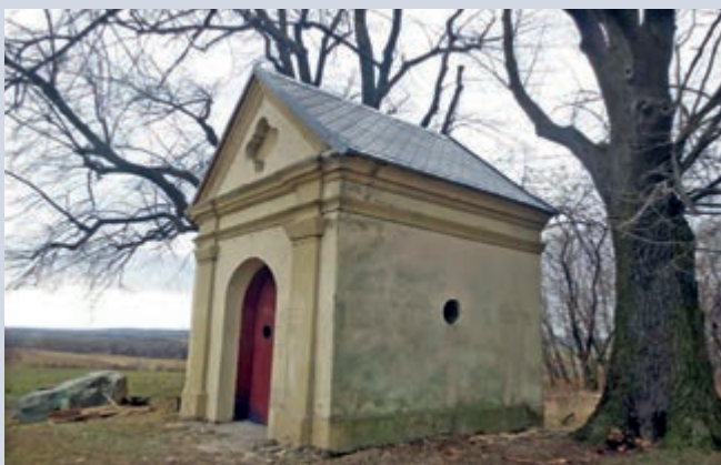
Kaple sv. Anny před obnovou, foto odbor strategického rozvoje Krajského úřadu Olomouckého kraje
