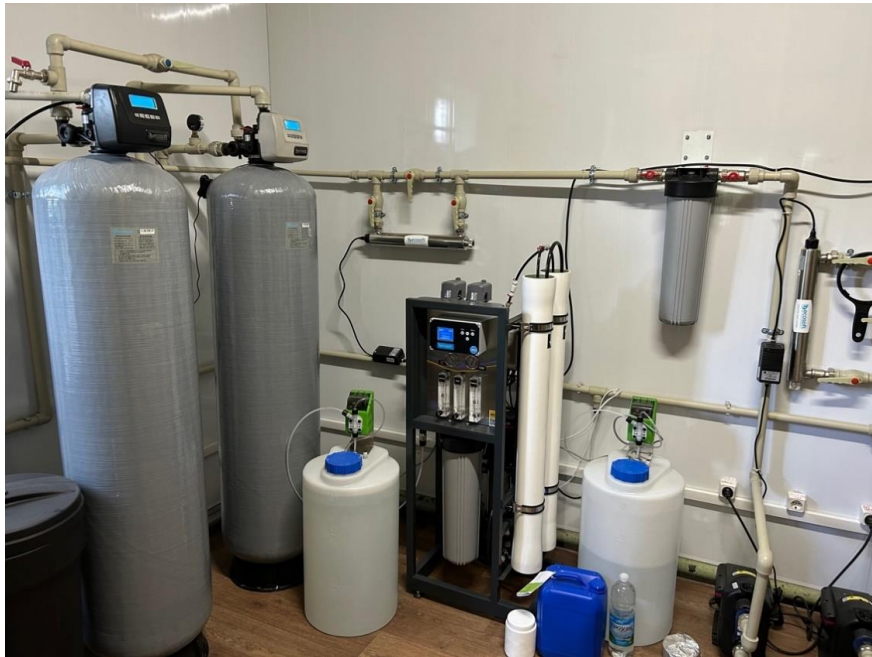
Obrázek 1: Typické schéma zařízení filtrační stanice o kapacitě 0,5 m3 pitné vody za hodinu
