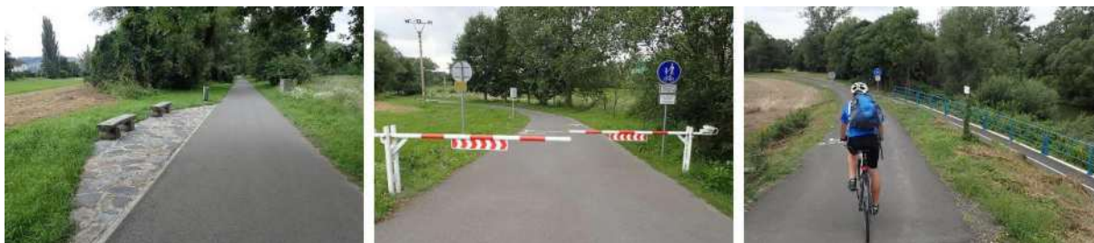
Extravilán – Cyklostezka Bečva – úsek Týn nad Bečvou – Osek nad Bečvou
