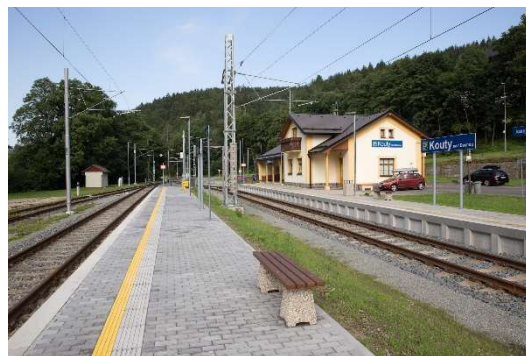
Obrázek 8: Železniční stanice Kouty nad Desnou
