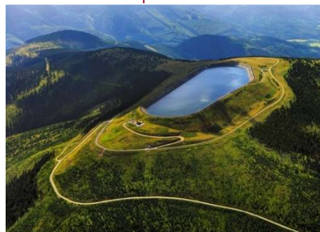
Obrázek 5: Přecherčpávací elektrárna Dlouhé
