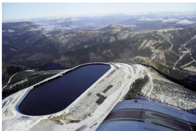
Přečerpávací vodní elektrárna Dlouhé stráně/Dlouhé Stráně Water-pumping Electricity Plant
