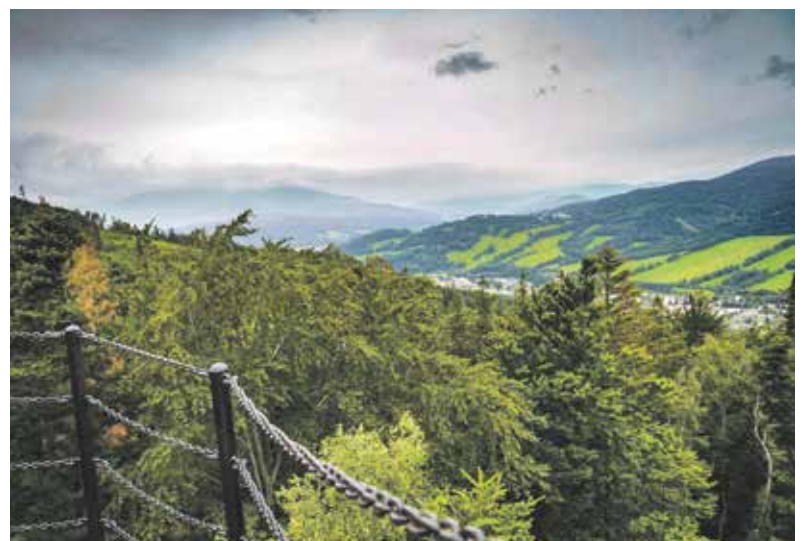
Vyhlídka na Čertových kamenech je znova přístupná veřejnosti. Vyhlídka na nedaleký Jeseník, Zlatohorsko, údolí Bělé a k Nyskému jezeru prošla rozsáhlou rekonstrukcí za finančního přispění Olomouckého kraje.
