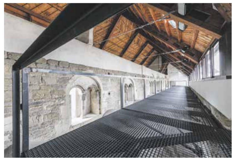
Novinkou je lávka nad klenbami ambitu v paláci biskupa Zdíka.
