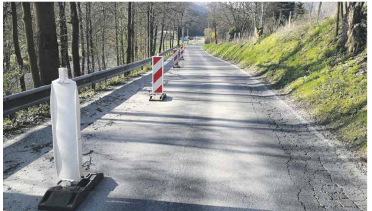
Silnice II/369 byla značně poškozena před dvěma lety sesuvem půdy. Ted' prochází opravou.
