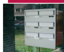
schránky jsou vně domu
